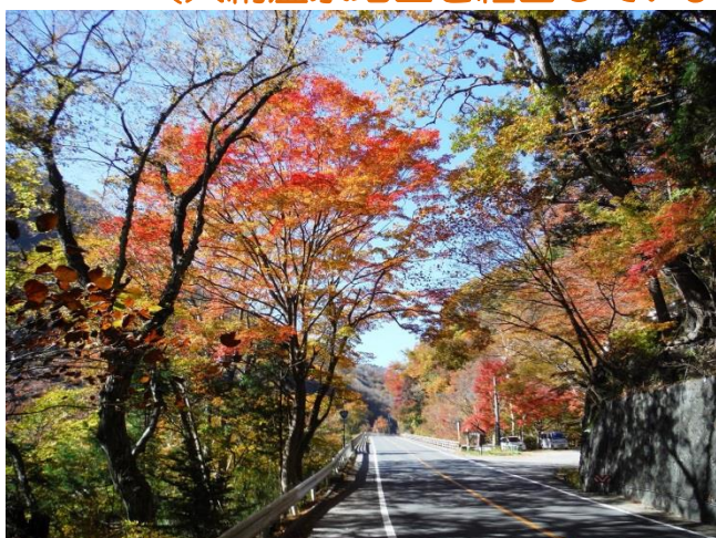
国道400号線(大網園地付近)
