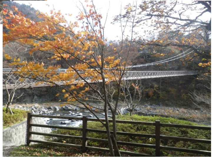
■七ツ岩吊橋 ビジターセンター対岸の駐車場より
